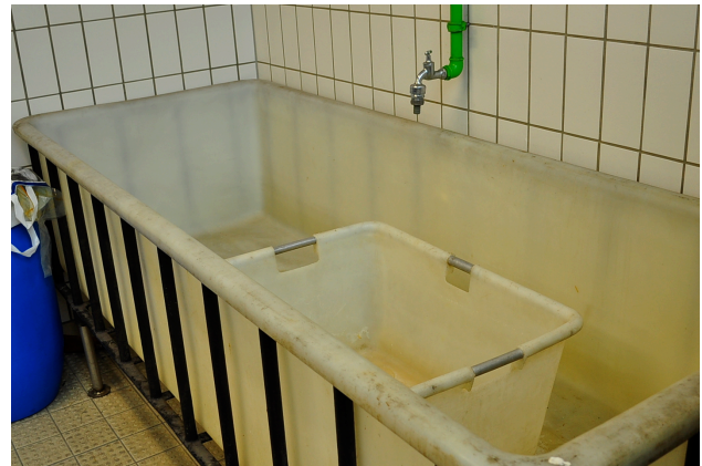
Abb. 15: Große Wässerungswanne im Mazerationsraum.
