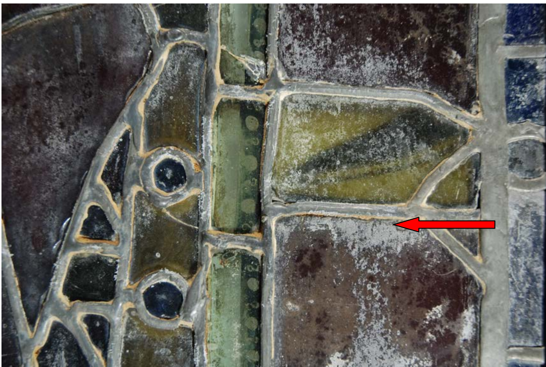
Abb. 16 München, BNM, Feld n IV 1d von ~1380, Detail der Außenseite im Auflicht, KO 1b-2b: weißlich verfärbte Bereiche in der oberen Glasschicht
