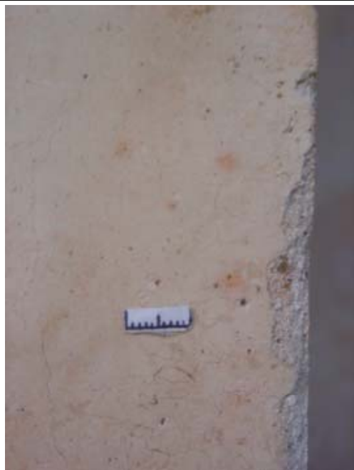
Abb. 44: Rosafarbener Befall an der westlichen Säule der Petruskapelle. (Foto aus: Granek und Leupold 2004, S.154)
