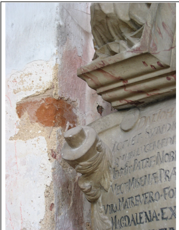
Abb. 47: Befallener Bereich links des Epitaphs Fritsch. Hier befindet sich der einzige höher angesiedelte Befall in knapp 2m Höhe. Auch hier gibt es keine direkte Sonneneinstrahlung.
