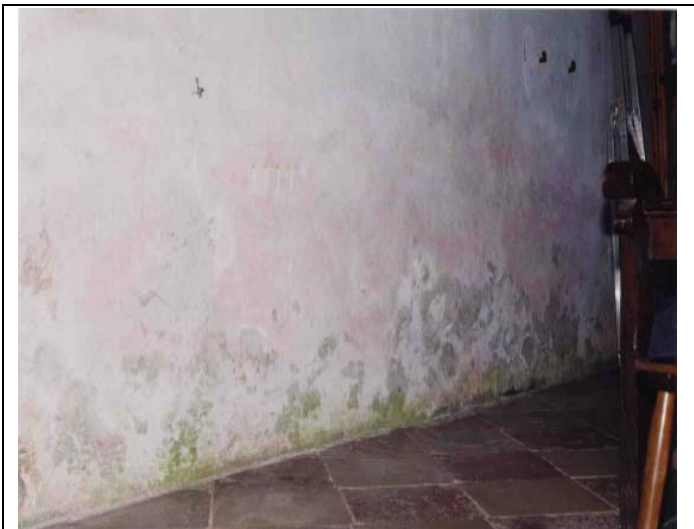
Abb. 14: Rosafarbener Befall der Südwand der Grabeskapelle. (Foto aus: Wörz 2000, S.30)
