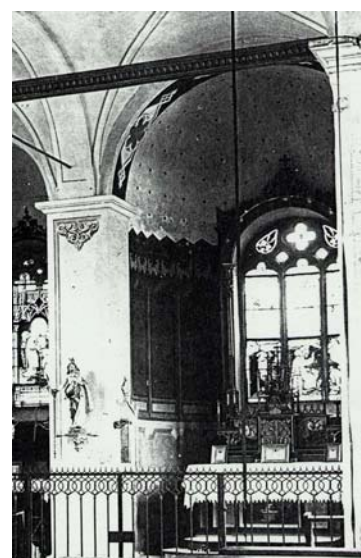
Abb. 55: Die Kirche Reichenau vor der Renovation (78)
