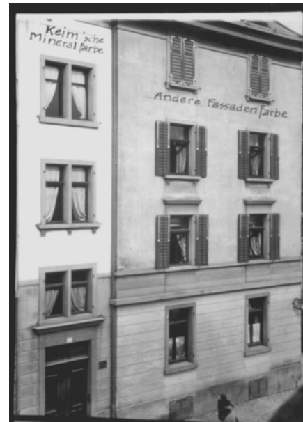
Abb. 46: Versuch mit Fassadenanstrichen 1920 (Nachlass Chr. S)
