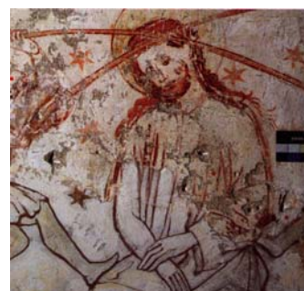
Abb. 68: Die Putzergängung von 1890/91 ist gut erkennbar. (Sennhauser et al., 1999: 51)
