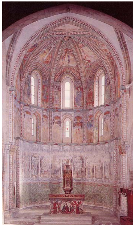
Abb. 74: Chor, nach der Restaurierung 1990. (Pradervand, 1997: 242)
