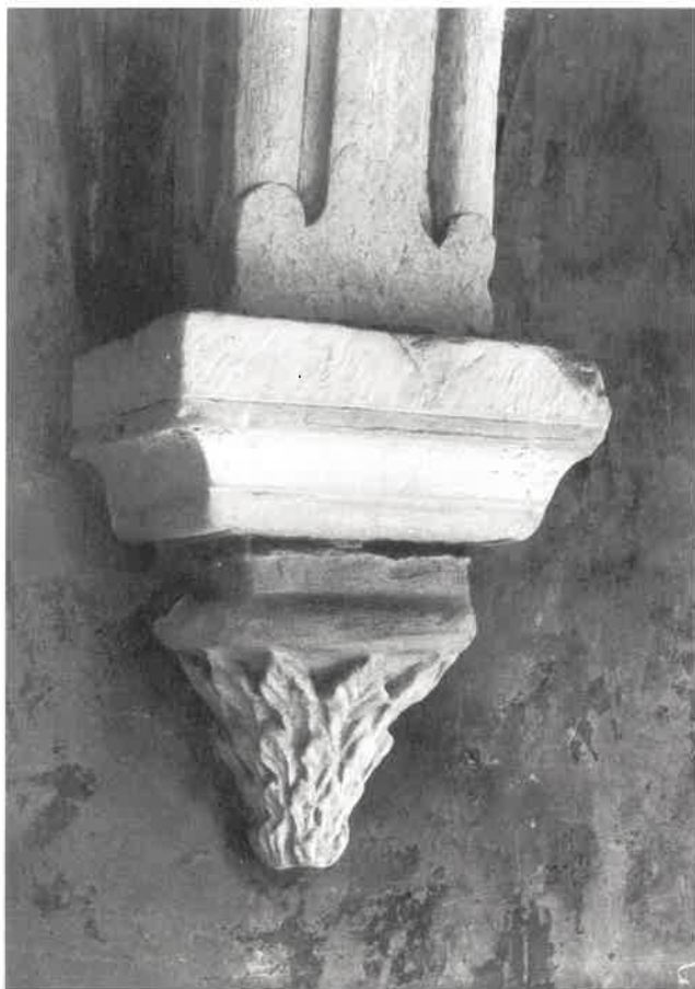
Abb. 10: Konsolkapitell an der Innenwand des nördlichen Kreuzarms zwischen dem vierten und fünften Joch
