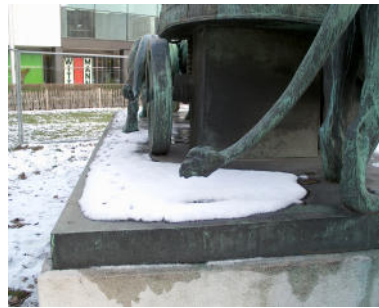
Abb. 293: MA-M, Plinthe: Unterschiedliche mikroklimatische Bereiche an der Oberfläche der Bronzeplastik, hier durch Schnee
