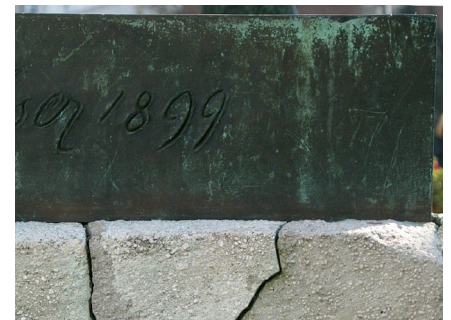
Abb. 141: MA-M, Ausschnitt des Auflagebereiches der Plinthe am Sockel, rundumlaufend ohne Ausbildung einer grünen Patina
