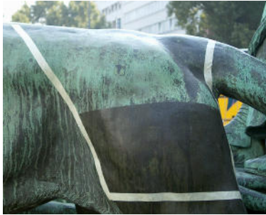
Abb. 209: MA-M, Versuchsfläche I zur Abnahme des Schutzüberzuges (mikrokristalline Wachsmischung); Zustand vor Abnahme
