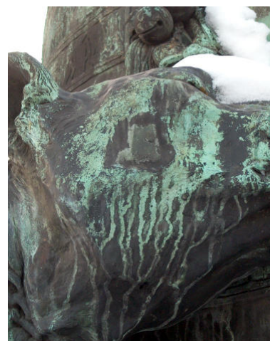
Abb. 290: MA-M, Löwin 3: Flicke aus der Reparatur nach dem Zweiten Weltkrieg, erkennbar an der dunklen Farbe der Oberfläche (vergleiche dazu Abb. 120)
