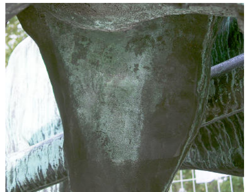
Abb. 302: Testfläche I – Arbeitsaufnahme; nach Abnahme von Verkru- stungen.
