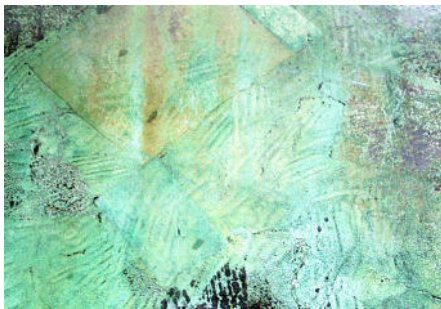
Abb. 46: Marc Anton-Monument, 2002, Löwin 3, Originale Flicke; an der Oberfläche wurde die Struktur der Flicke der Fellstruktur angeglichen. Die Oberfläche der Flicke zeigt ein von der Umgebung etwas abweichendes Verwitterungsbild.
