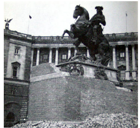
Abb. 36: Prinz Eugen Denkmal, Wien I., Heldenplatz, zu Ende des zweiten Weltkrieges: Mit einer Ziegelummauerung sollte es vor Kriegseinwirkungen geschützt werden. Ein Aspekt der Geschichte des Denkmalschutzes, der zwischenzeitliche Extreme dokumentiert. 106
