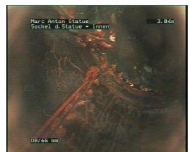
Abb. 234: MA-M, Thronwagen, Eisenteile teilweise mit Mennige-Anstrich geschützt, teilweise stark korrodiert
