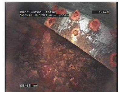
Abb. 107: MA-M, Innenbereich des Sockels, Flanschenverbindungen der Plinthe (Endoskopie). Die zur Befestigung dienenden Eisen-schrauben sind mit einem Mennige-Anstrich als Korrosionsschutz versehen.
