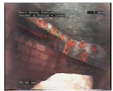
Abb. 231: MA-M, Plinthe, Kondensat an Metall/Patina, mit Mennige-Anstrich geschützte konstruktive Elemente aus Eisen/Stahl, Stützmauer unter Thronwagen, geschlossene Patina an der Bronze in kräftigem Grün
