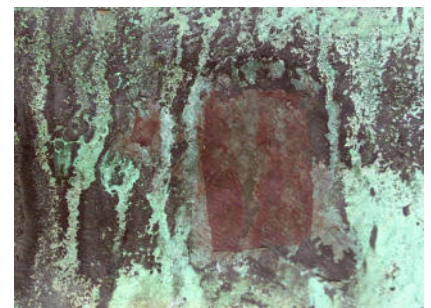
Abb. 47: Marc Anton-Monument, 2002, Löwin 2, Flicke aus Reparatur nach 1945; die Oberfläche zeigt ein abweichendes Verwitterungsbild; eine grüne Patina kann sich nicht ausbilden. Ein Indikator für ein vom originalen Bronzematerial zu unterscheidendes Metall für die nach 1945 ausgeführten Reparaturen.
