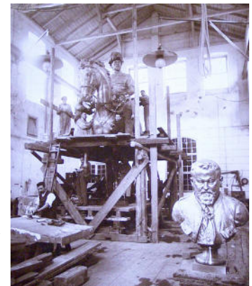
Abb. 34: Im Gusshaus, 1889 (Bezirksmuseum Wien VI., Wien), Erzherzog Albrecht Denkmal, Montage und Überarbeitung des Gusses
