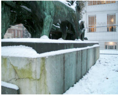
Abb. 292: MA-M, Plinthe: Ansammlung von Schnee im Zwickel Plinthe / Bronze
