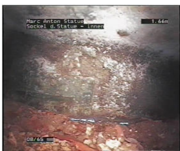
Abb. 230: MA-M, Plinthe, unregelmäßige Auflage am Sockel, Kondensat an Metall/Patina
